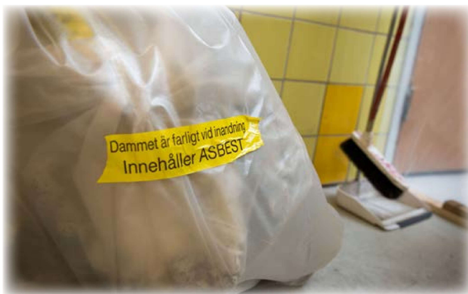
Asbestavfall i tätförsluten plastsäck. Foto: Hans Alm, Arbetsmiljöverket
