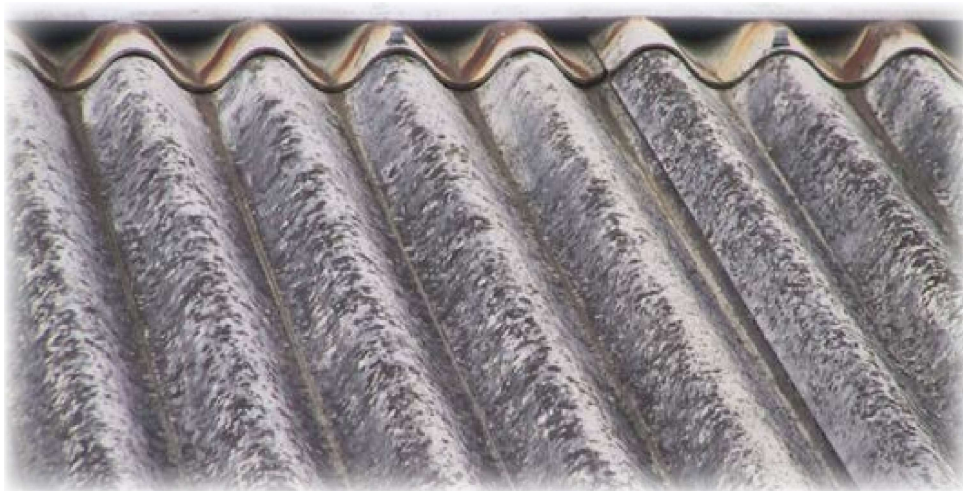
Tak av eternit. Foto: Alsglobal
