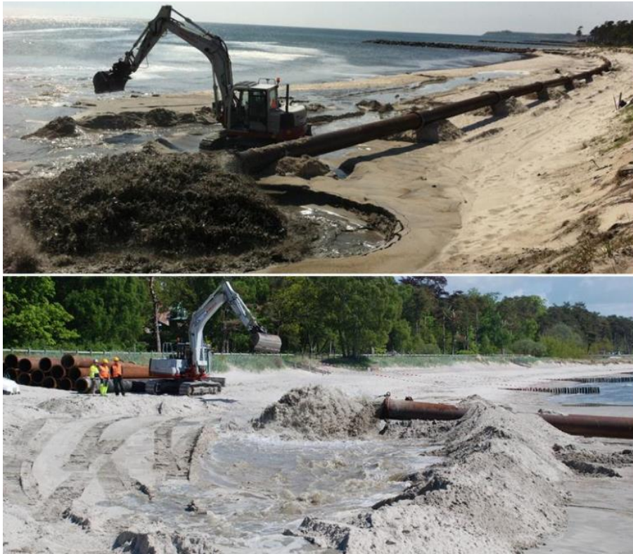
Figur 4.15. Strandfodring med rörledning från fartyg i Ystad. Källa: (Sweco, 2013).
