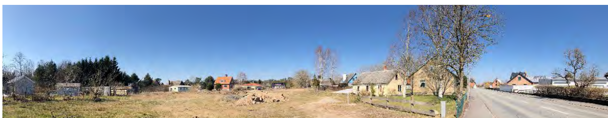
Vy från Yngsjövägen mot planområdet, till vänster angränsande komplementbyggnader inom Åhus 42:183. Foto: Evelina Simonsson
