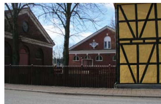
Korsvirke och tegel på Norra Kasern.
