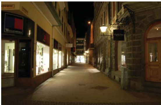
Väggmonterad armatur på Hesslegatan.
