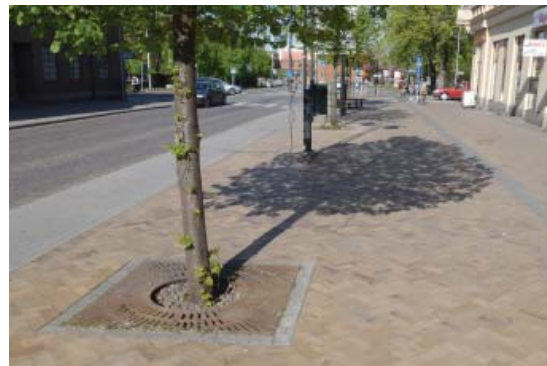
Nya Boulevardens olika beläggningar.
