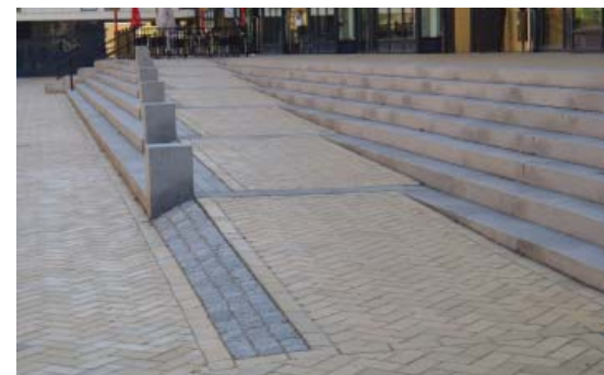
En utvändigt ramp är lika självklar som trappan, Södertorg.
