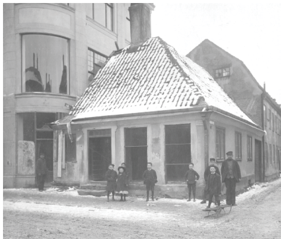
I samband med att byggnader rivs och ersätts med nya breddas stadens gator.
