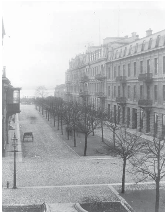
Vy över Nya Boulevarden efter att Tvärkanalen lagts igen.
