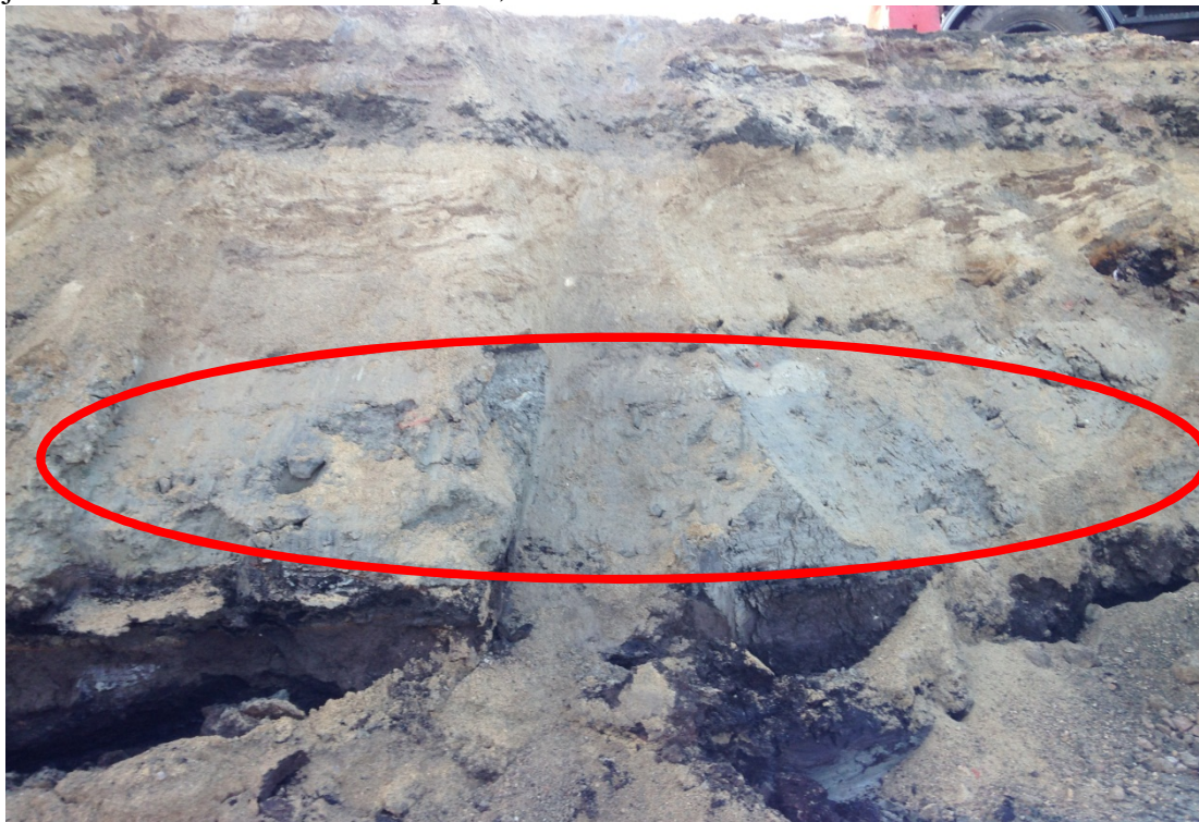
Bild 3. Foto taget vid schakt av petroleumluktande jord vid delområde 2, se röd cirkel
