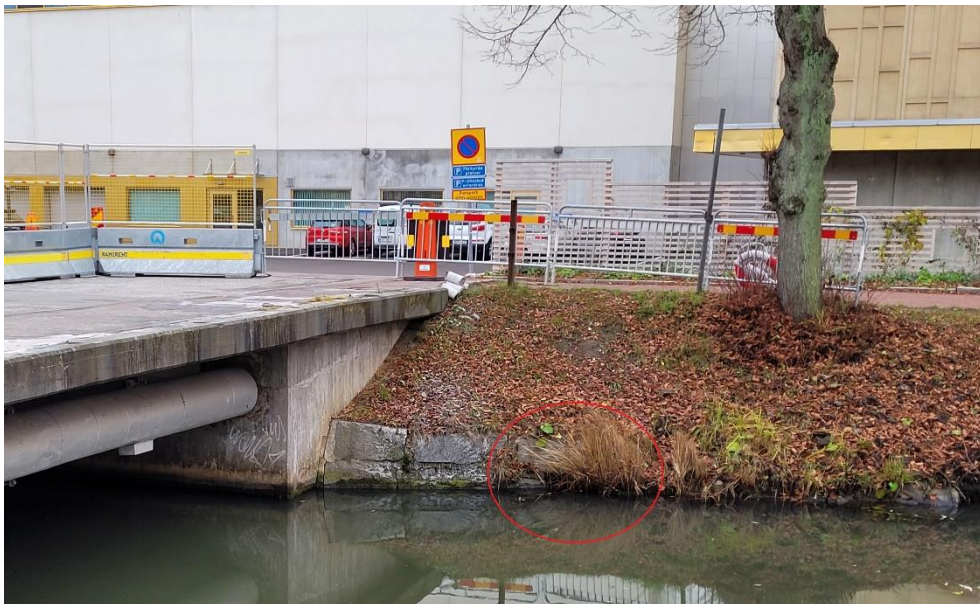
Figur 10. Möjligt utlopp på den västra sidan av bron, markerat i rött. Utloppets exakta position är ej bekräftat, möjligtvis på grund av den höga vattennivå i kanalen. Kvarter C syns i bakgrunden.
