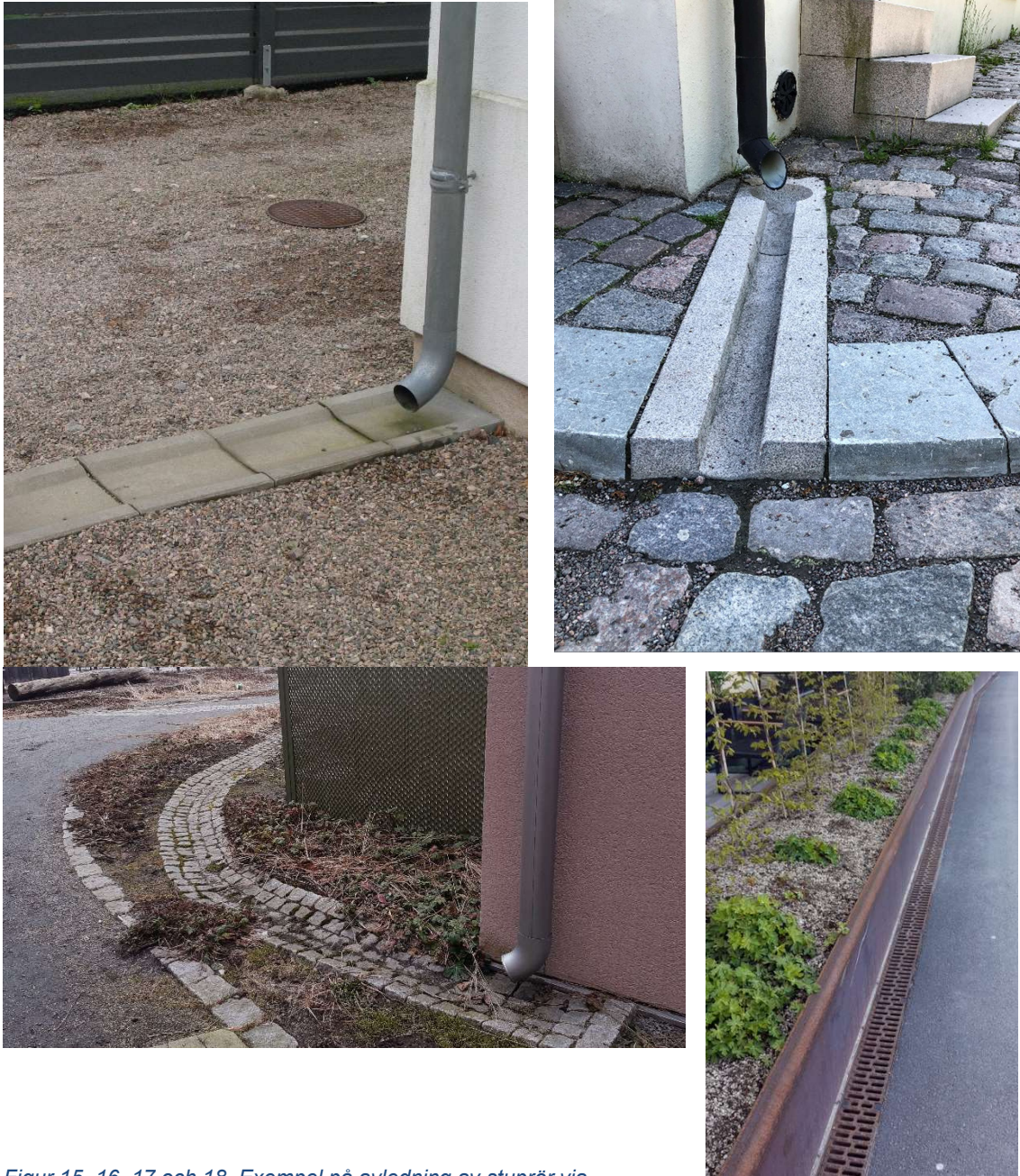
Figur 15, 16, 17 och 18. Exempel på avledning av stuprör via rännalsplattor och ytvattenrännor i olika utföranden (Tyrens, 2022).
