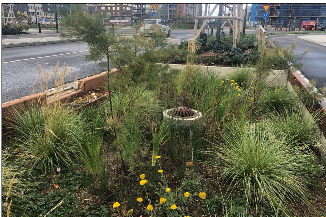
Figur 19. Exempel på en regnbädd. De kan planteras med både träd, buskar, perenner och prydnadsgräs. (foto: Tyréns AB).
