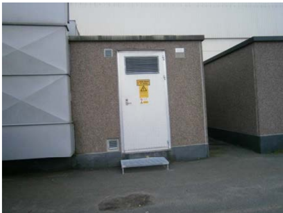
Figur 23. Det finns 2 st. transformatorer på gården från 1989, dessa är för nya för att innehålla PCB men kan innehålla oljor. Töms på olja innan rivning och sorteras som metallskrot. Tillhörande styrutrustning sorteras som el-avfall.
