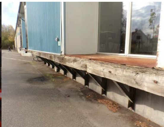
Figur 26. Påkörningskydd på lastkaj i söder är i tyckt virke.
