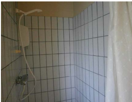
Figur 3. Äldre kakel som sitter i bruket innehåller ej asbest, dock innehåller de höga halter av bly och skall därför separeras ut och klassas som kakel innehållande farliga ämnen.
