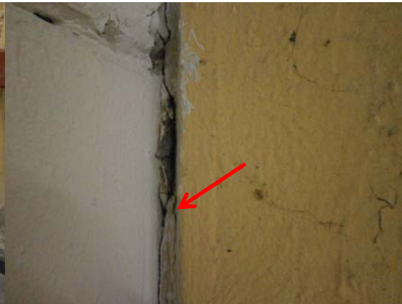
Figur 8. Närbild på asbestfog bakom pelare.
