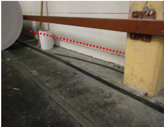
Figur 7. Invändig fog mellan betongsöcket och lättbetongfasad innehåller asbest. Utvändig är fogar av kallasfalt.
