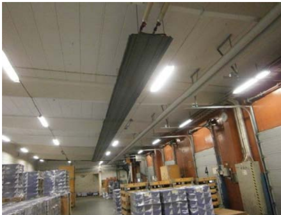
Figur 15. I byggnaderna finns betydande mängder lysrörsarmatur, vissa äldre har PCB-kondensatorer.
