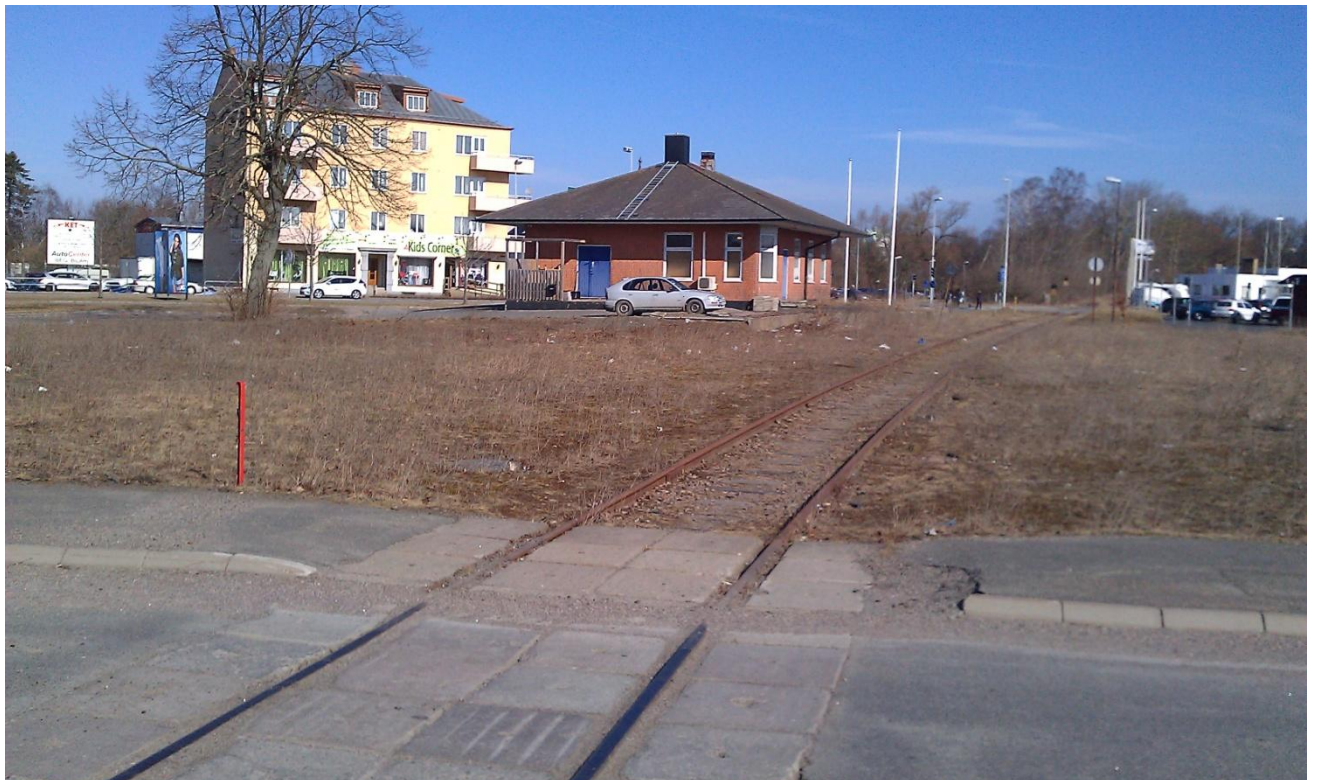
2011-03-22 Norra delen av Slakteriet 4 sett från söder.
