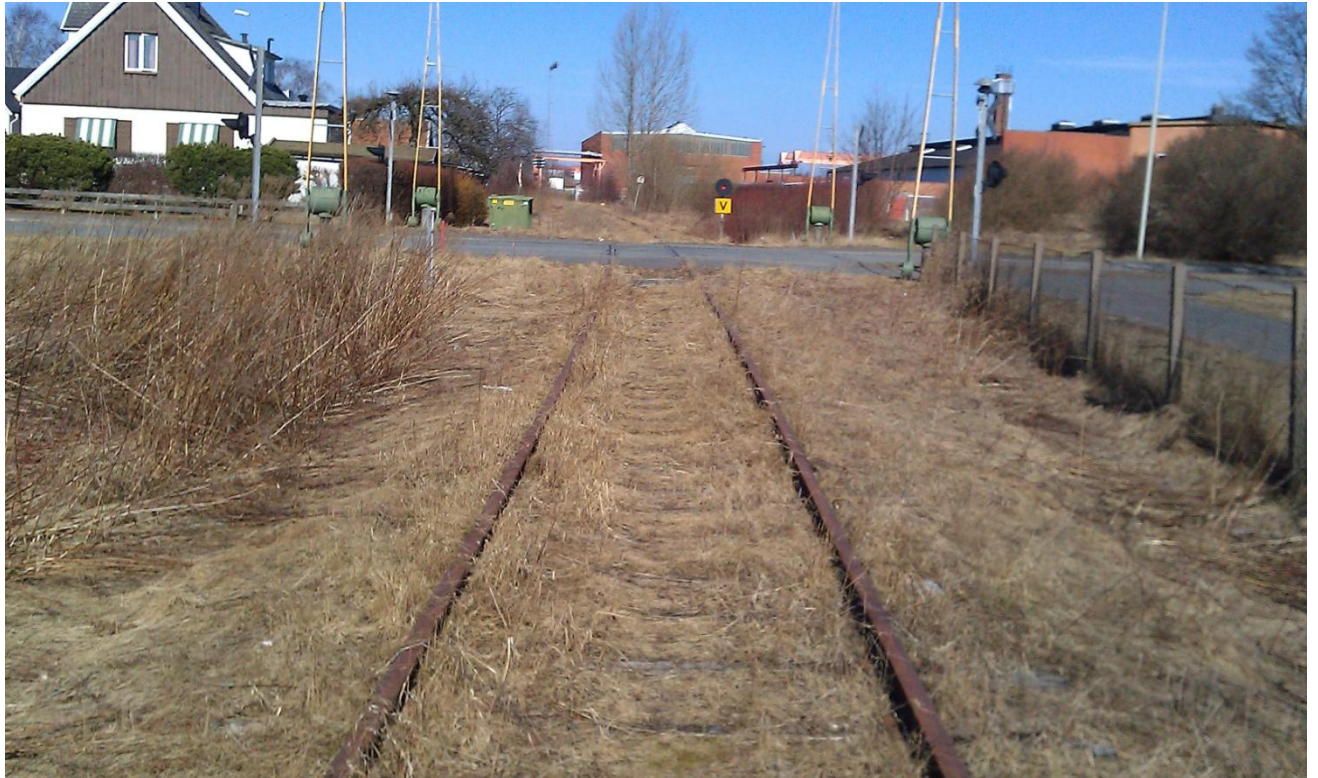
2011-03-22 Del av banvallen längs med Långebrospåret, mellersta delen sett från söder.
