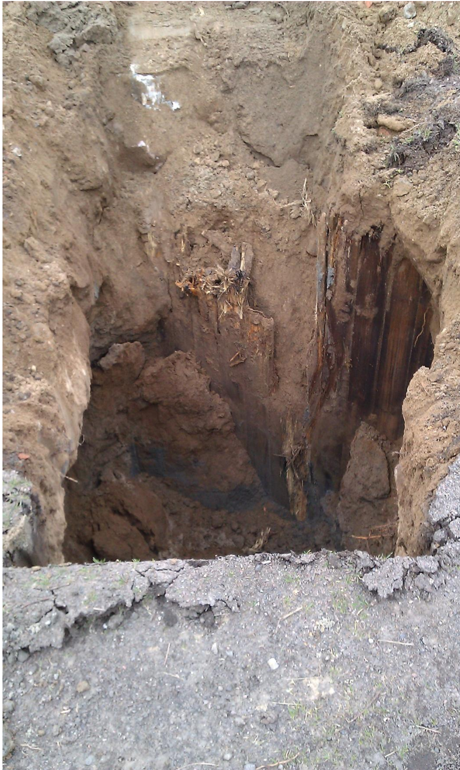
2011-04-05 PG6, petroleumlukt och vertikala plankor. Fd cisterngrop?
