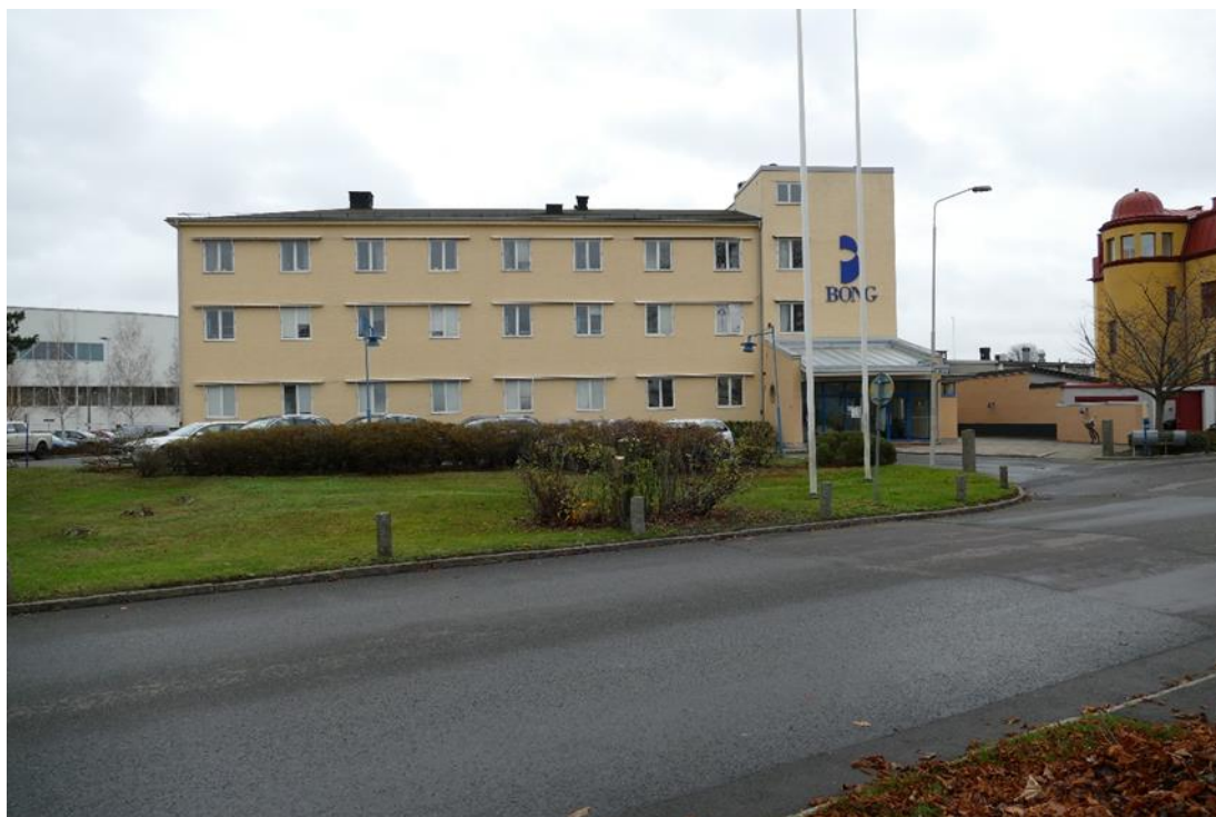
Företaget Bongs kontorsbyggnad i funktisstil. Till vänster i bild skimtar Kristianstad arena och till höger en jugendbyggnad som idag buserar kontor för flera företag.
