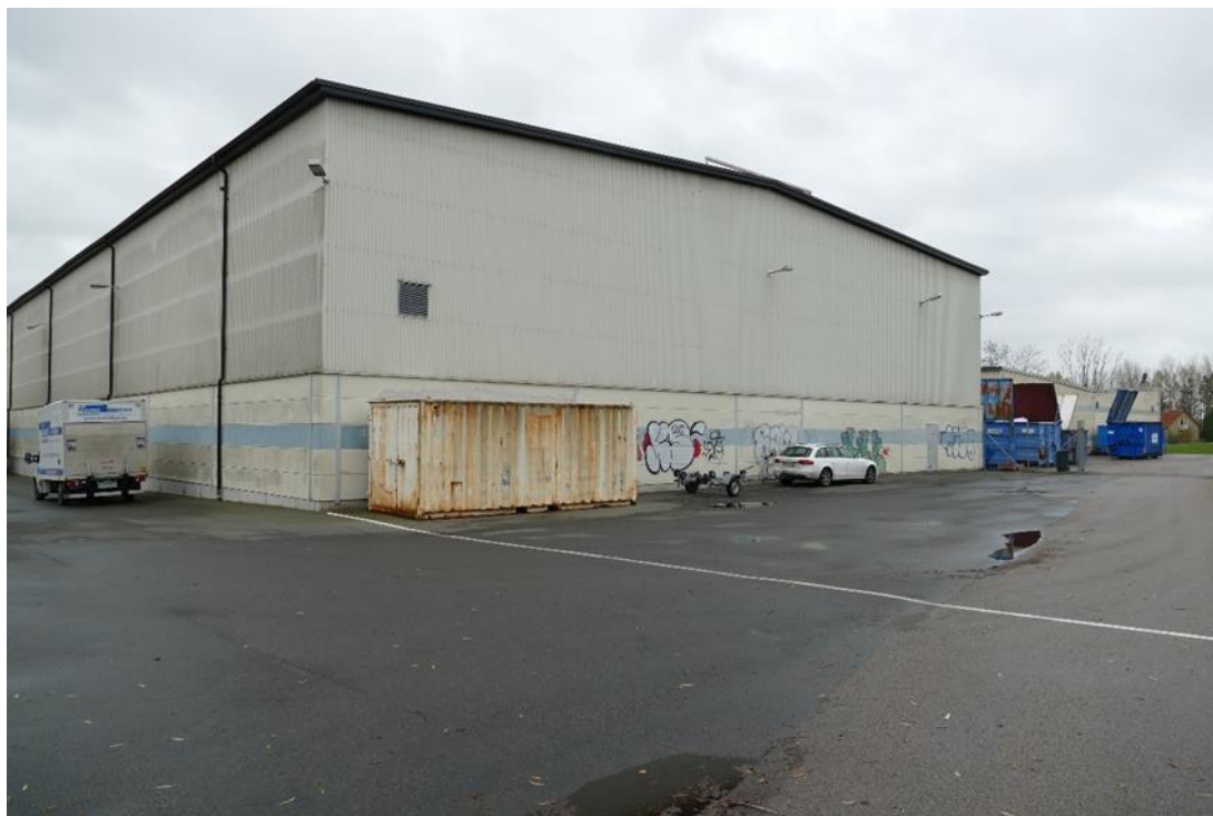
Bongs sentida produktionsanläggning på fastigheten Yllefabriken 20. Anläggningar av den här karaktären är vanligt förekommande inom yngre industriell bebyggelse.
