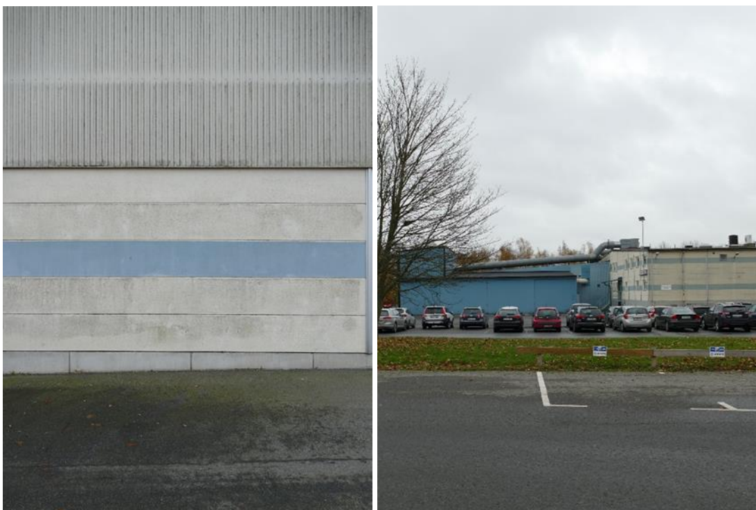
Vänstra bilden visar detalj av fasad med för anläggningen kännetecknande horisontellt band i ljusblått. Till höger två byggnadskroppar klädda med blå korrugerad plåt, som genom den blå kulören ansluter till övrig anläggning i prefabricerade betongelement.
