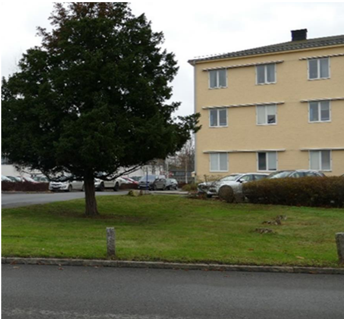
Platsbildning framför kontorsbyggnaden på fastigheten Konservfabriken 8.
