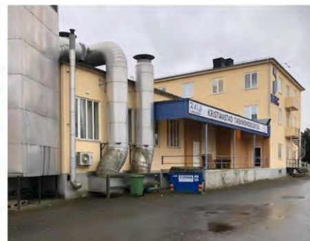
Byggnaden består av flera byggnadskroppar i funktionalistisk stil
