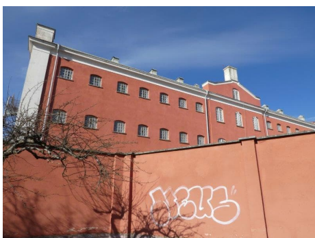
Huvudbyggnad och mur mot öster
