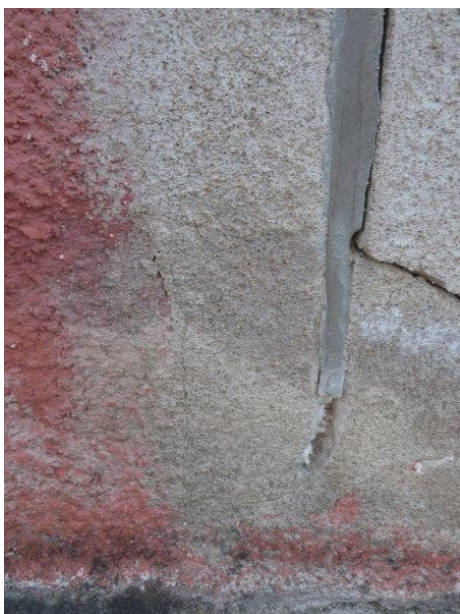
Prov nr. 01 – Mur, norra sidan
