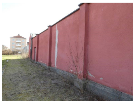
Mur mot norr
