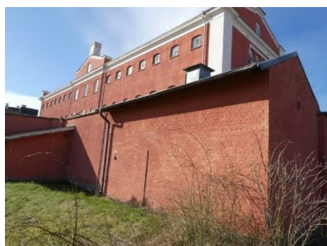
Huvudbyggnad och mur mot öster
