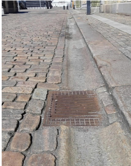
Figur 11. Ränna med galler t.h. och nedsänkt ränna i sten t.v. Foto: Tyréns AB
