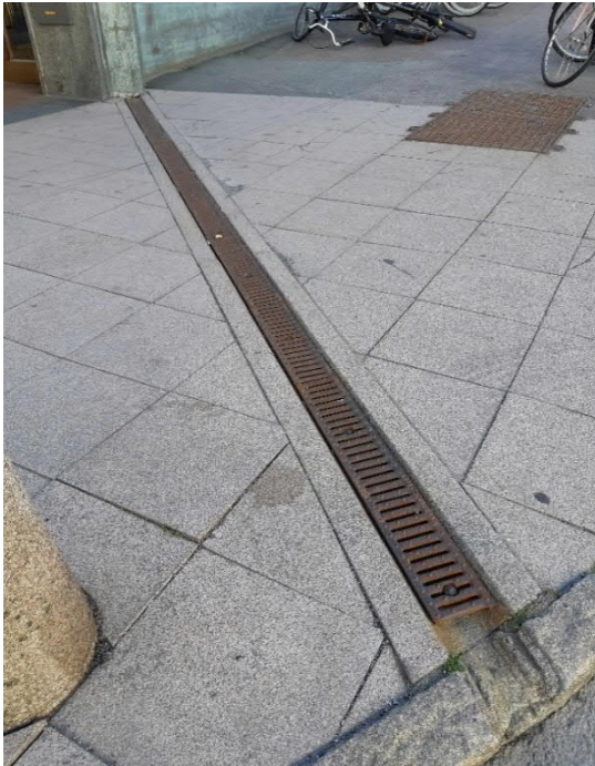
Figur 11. Ränna med galler t.h. och nedsänkt ränna i sten t.v. Foto: Tyréns AB
