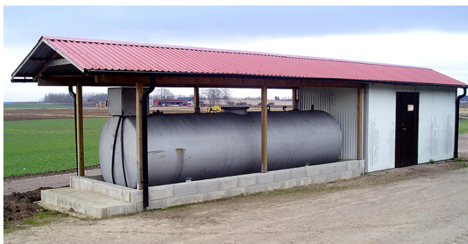
Ett bra exempel på cistern med invallning och nederbördsskydd
