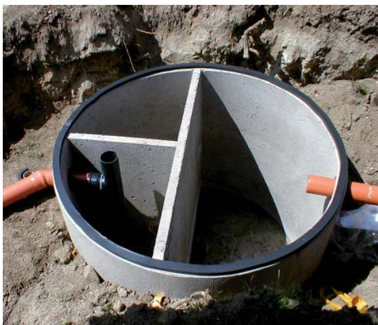
Trekammarbrunn för slamavskiljning.
