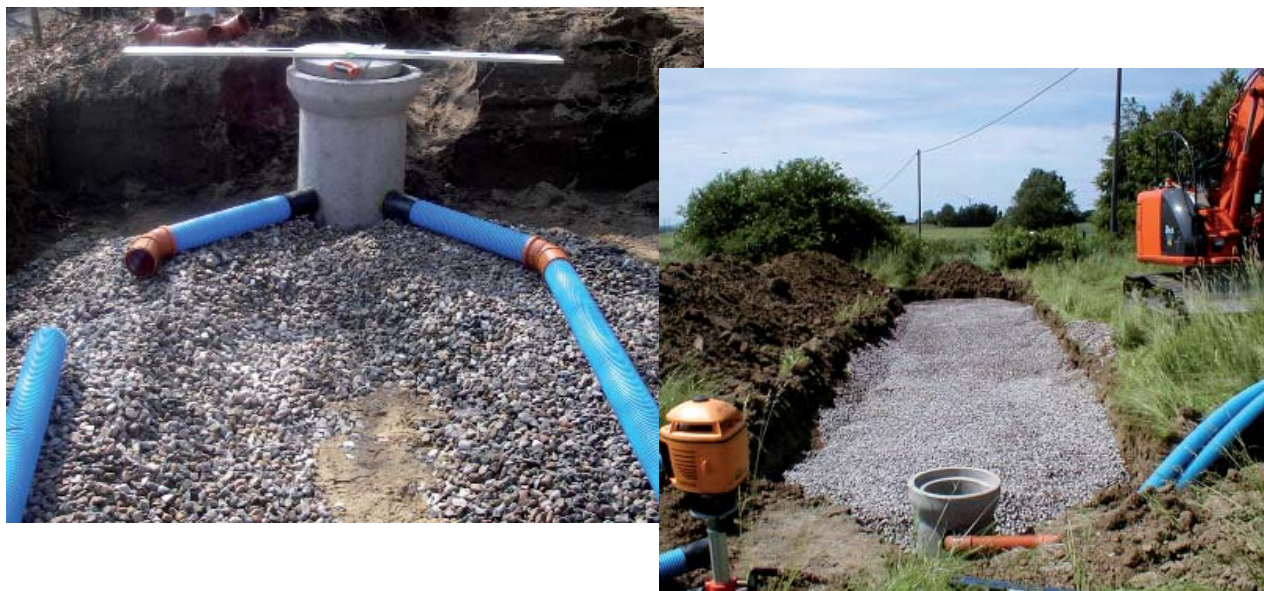
Slamavskiljare och utläggning av rör för infiltration.
