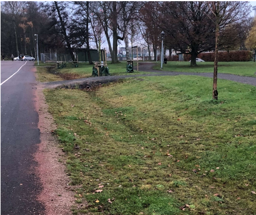
Figur 13. Exempelbild på dike med flacka slänter (Foto: Tyréns)
