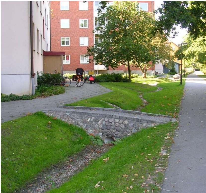
Figur 14. Makadamdike med kross på ytan (Foto: Tyréns)
