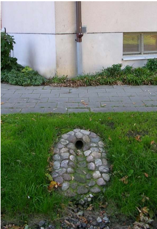
Figur 11 och 12. Exempelbilder på hur dagvatten från tak via stuprör kan ledas ut från byggnader via rännalsplattor eller liknande till grus- eller gräsytor. (Foto: Tyréns)
