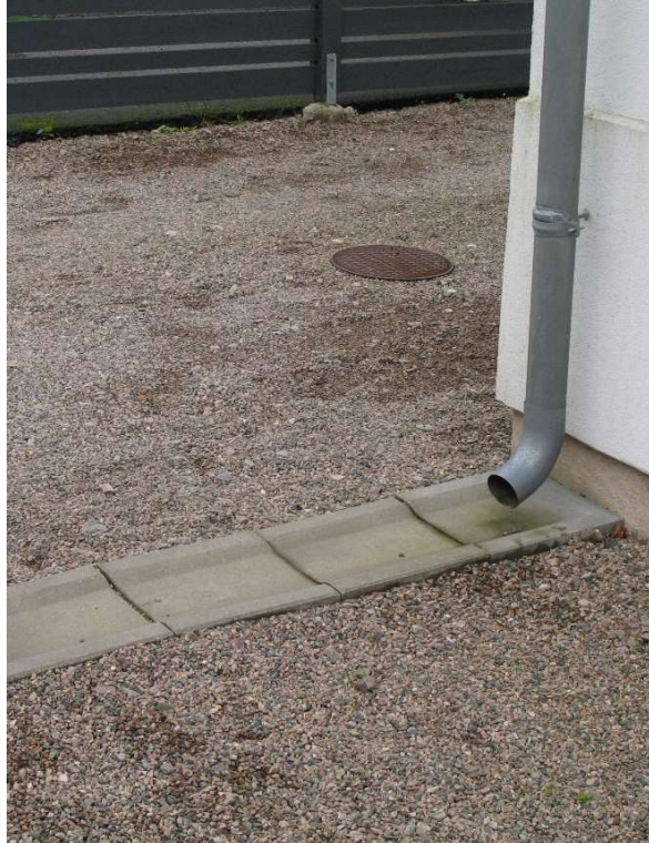
Figur 11 och 12. Exempelbilder på hur dagvatten från tak via stuprör kan ledas ut från byggnader via rännalsplattor eller liknande till grus- eller gräsytor. (Foto: Tyréns)
