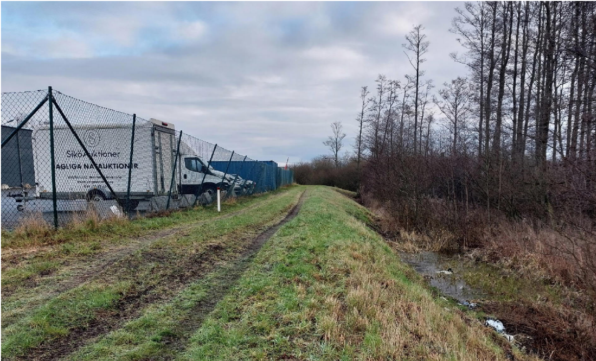
Figur 6 Typisk miljö längs stora delar av planerad vallsträckning, med industrifastigheter på västra sidan och blöt ogenomtränglig buskvegetation på den östra sidan. Gräsytan på bilden utgör befintlig skyddsvall (Foto: WSP)
