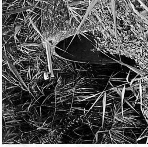
Nivåmätning av Dagvattendike
