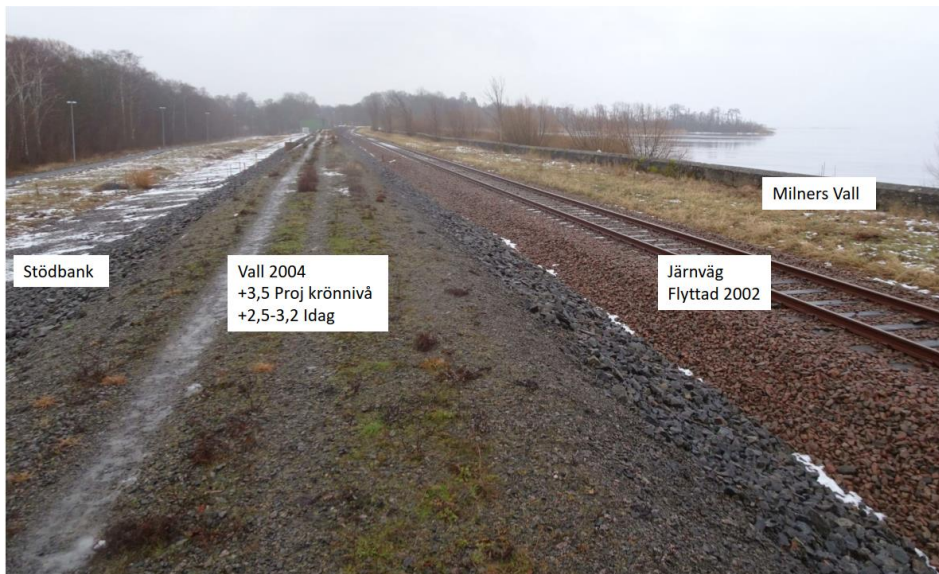
Figur 2 Foto 2019 över befintligt markområde med Milners vall, järnvägsspåret samt vallen från 2004 med tillhörande stödbank.
