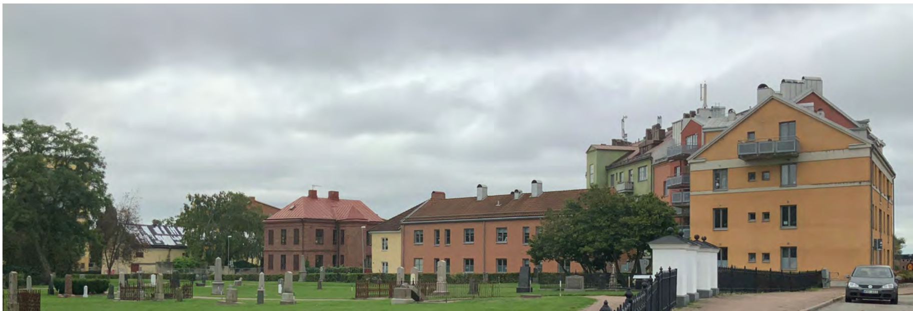
Vy från Långebrogatan över Gamla begravningsplatsen mot Kyrkogårdsgatan. Tillägg från 1990-talet, till höger i bild, är väl anpassad till den äldre bebyggelsen.
