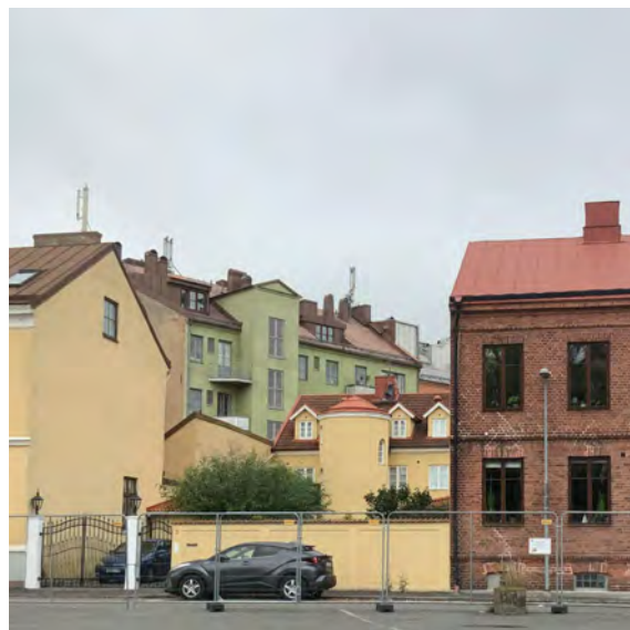
De olika byggnadshöjderna, vilket förstärks av den sluttande marken, ger variationsrika vyer över bebyggelsen.
