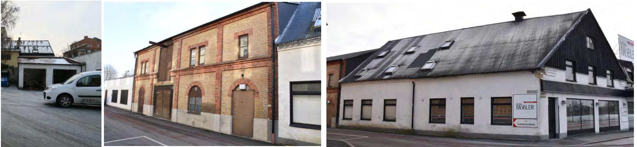
Figur 14. Kvarteret Vapenbrodern med fasader mot Beckhovsgatan.
