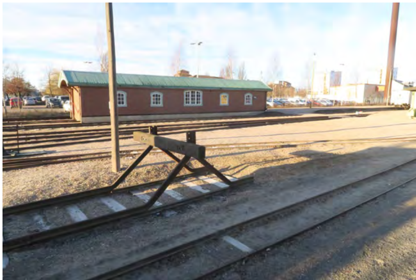
Figur 8. Järnvägsområdet med äldre järnvägsrelaterad bebyggelse.
