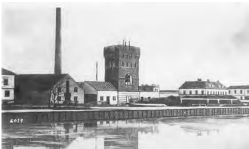
Figur 36. Lastageplatsen tidigt 1900-tal. Det höga tornet uppfördes som destilleringsverk åt vin- & spritbolaget L.O. Smith & Co. Foto: Regionmuseet Kristianstad.
