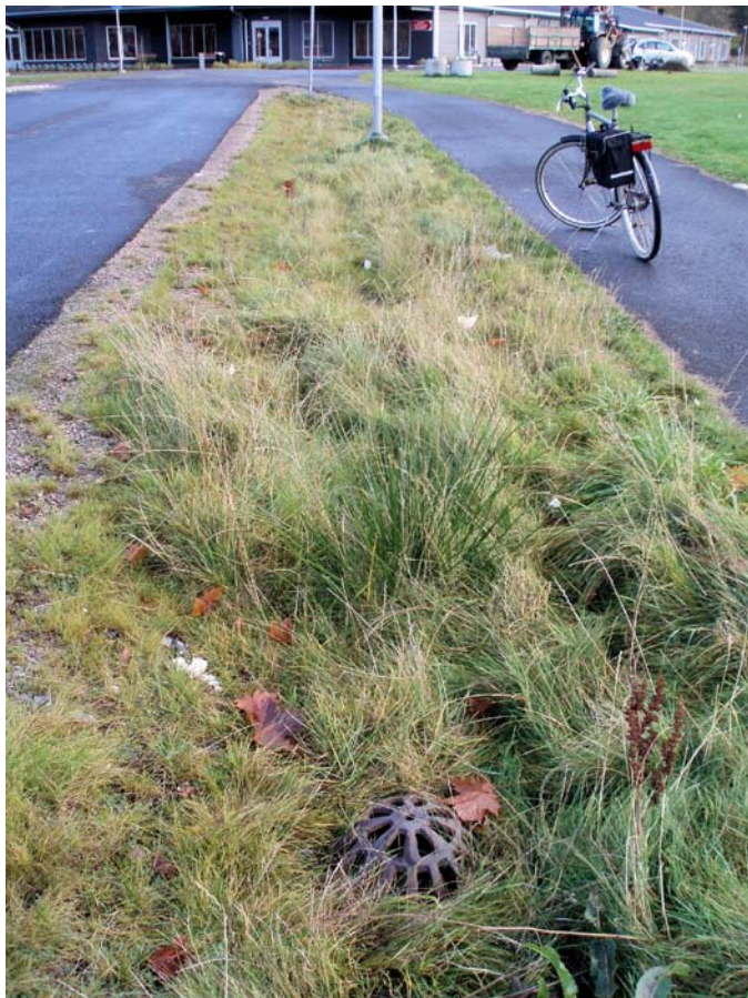
Gröna stråk mellan gator, parkeringsplatser och GC-vägar kan användas för avledning av dagvatten och överskottet bräddas ut via kupolventiler. Ventilerna kan höjas upp en aning så vattnet inte avleds för fort. Bild från Ishallen.
