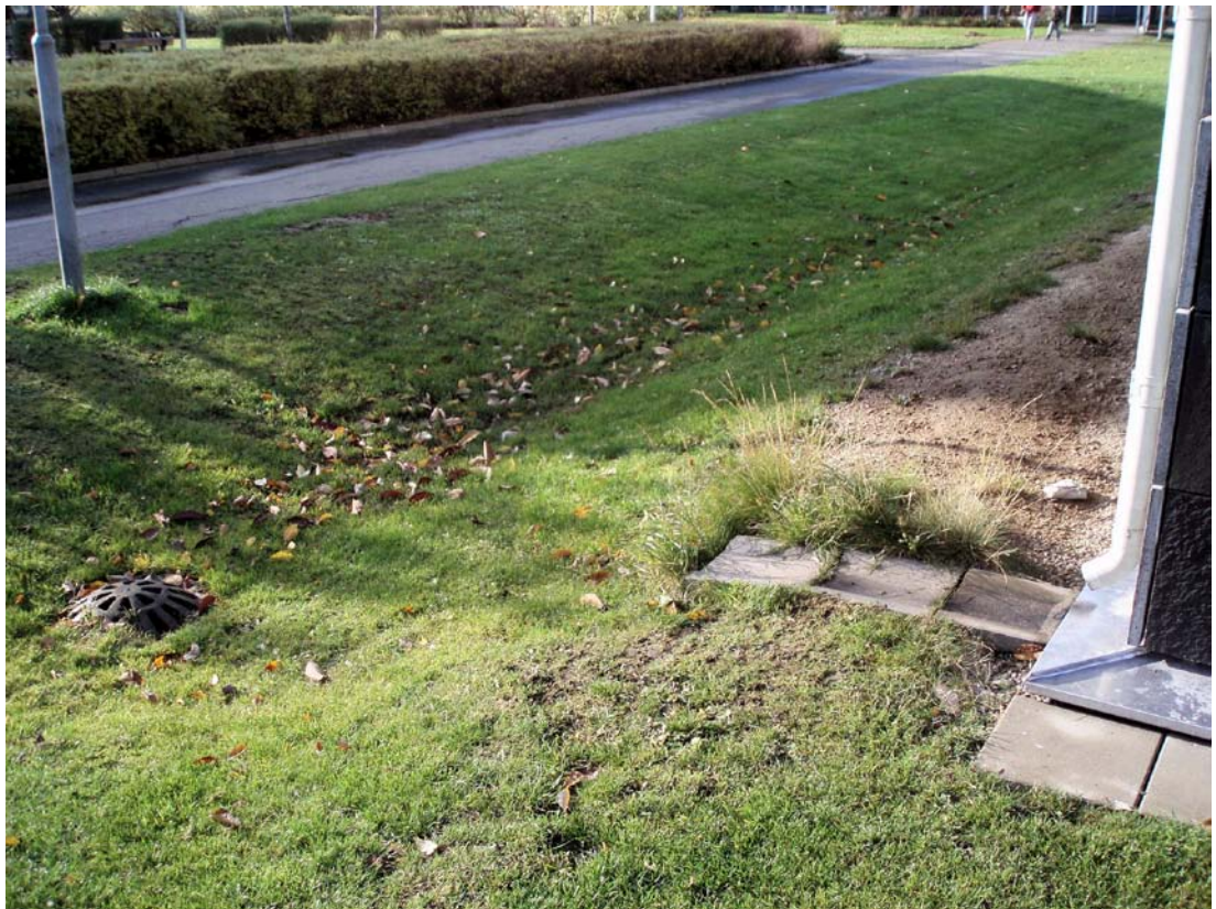
Takvattnet från stuprännan leds ut en bit från husfasaden och vidare till gräsmattan. Det som inte avdunstar eller infiltrerar bräddas över till ledningssystemet. Marken lutar från huset. Bild från Österäng.
