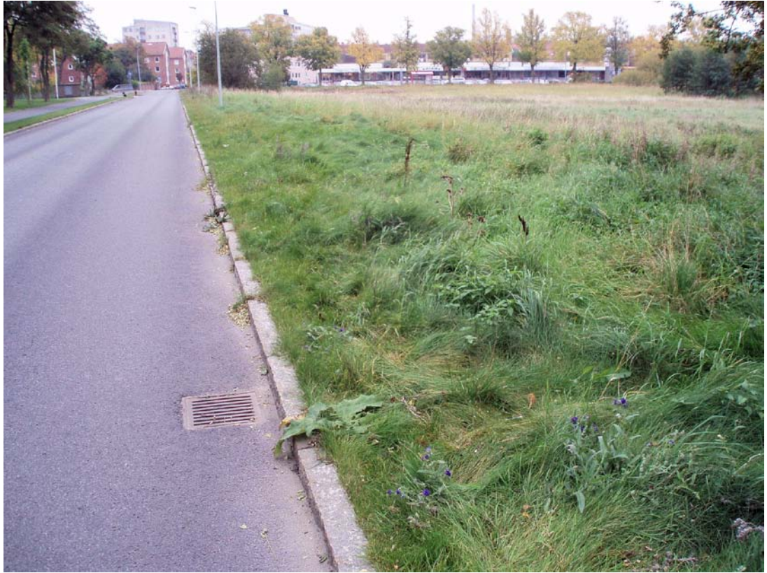
Ibland kan kantstenar och gatubrunnar slopas helt och vägvattnet istället ledas ut på lägre liggande grönområden intill. Bild från Ö Kaserngatan/ Utanverken.
