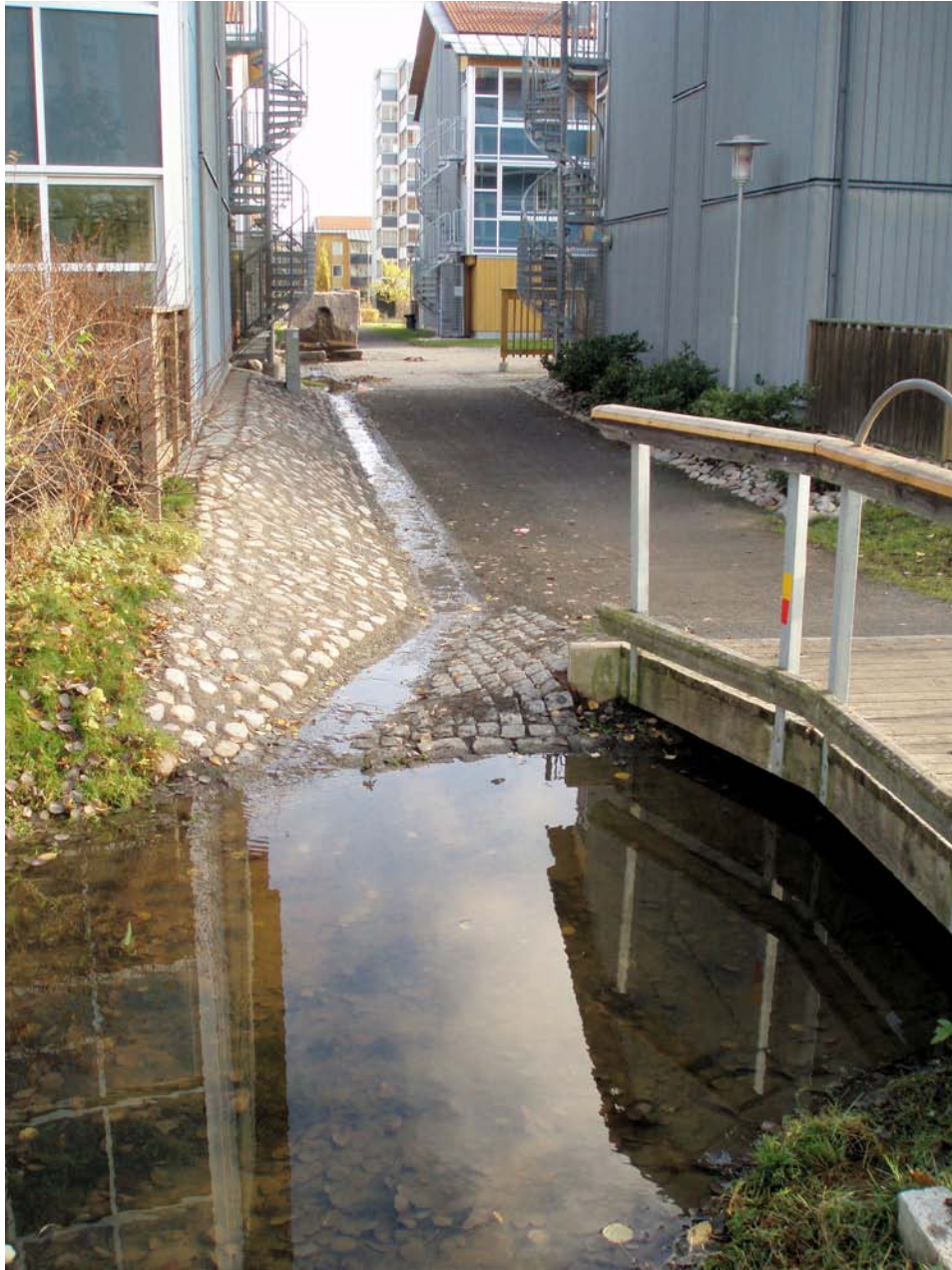
Öppen avledning av dagvatten. Bild från Österäng.
