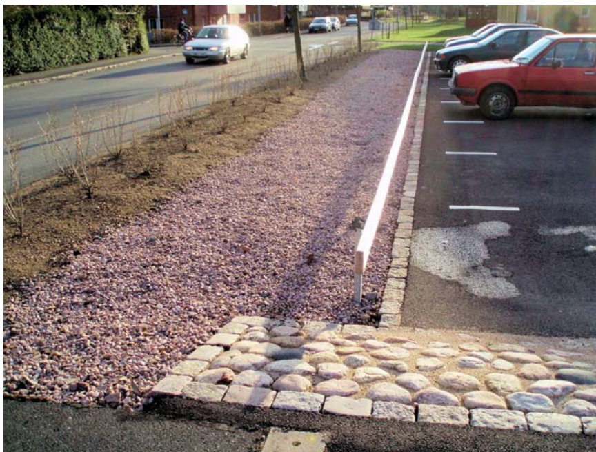
Parkeringar kan avvattnas mot ytor med genomsläppligt material vilket både minskar och renar dagvattnet innan det eventuellt avleds vidare. Bild från Näsby.
