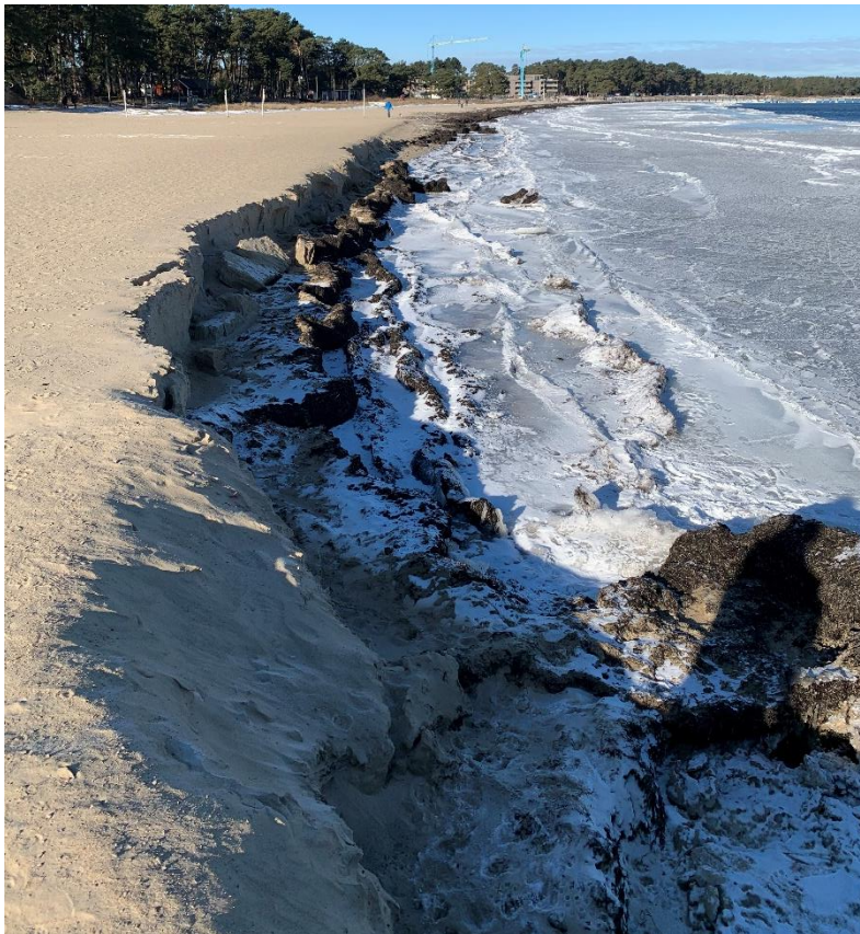
Figur 4-3 Erosionskanter i direkt anslutning till stenskoningen vid Evenemangsstranden (Bild: Sweco, 2020).
