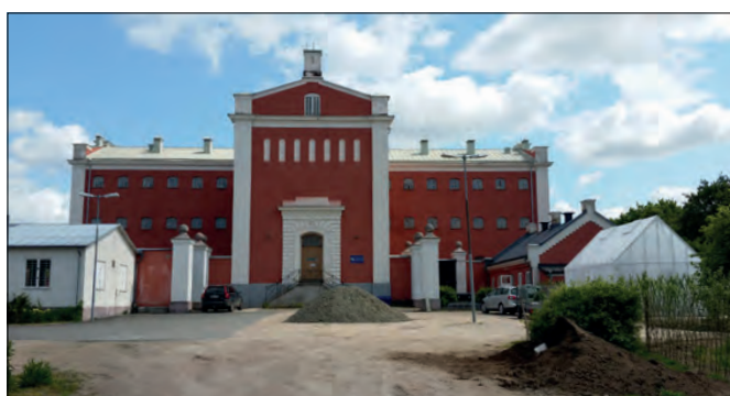
Entréfasad mot väster
