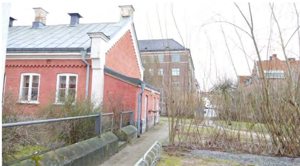
Byggnaden till vänster, kallad Södra flygeln, uppfördes som arbetslokal men byggdes senare om till personalbostäder. I anslutning till byggnaden finns en gjuten låg mur försedd med räcke och parallellt med den plattsatta trädgårdsgångar, en struktur som tydligt visar att trädgården var en del av fängelsets verksamhet.
