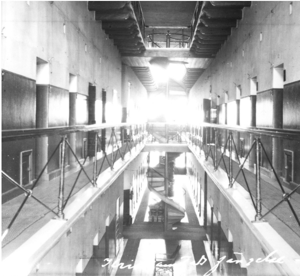
Interiör från cellängan 1905. Mellan våningsplanen fanns ett öppet ljusschakt för att underlätta övervakning. Längan fick naturligt ljus från fönstren i gavlarna och lystes i övrigt upp av fotogenlampor. Observera de små luckorna på sidan om celldörrarna, där nattkärnen kunde placeras så att dörrarna inte behövde öppnas. Ljusschakten byggdes igen under 1950-talet. Bild ur Regionmuseet Skånes arkiv.
