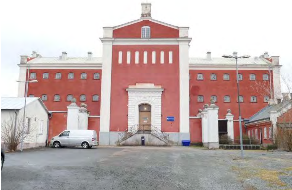
Fängelsets västra fasad med huvudentré visar tydligt institutionsbyggnadens monumentalitet.
