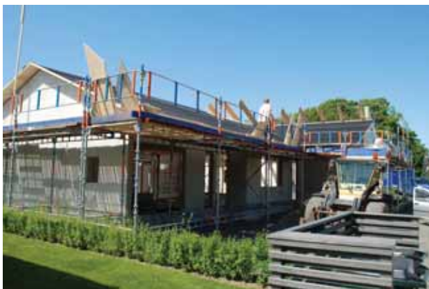
Byggarbetsplats i Tollarp
