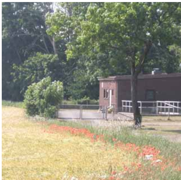
Avloppsreningsverk i Gärd's Köpinge.
