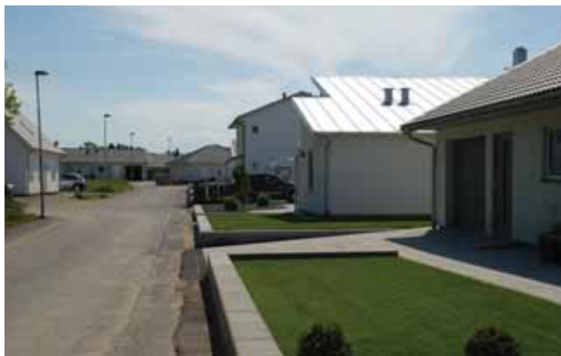
Nybyggda villor i Hammarlund
