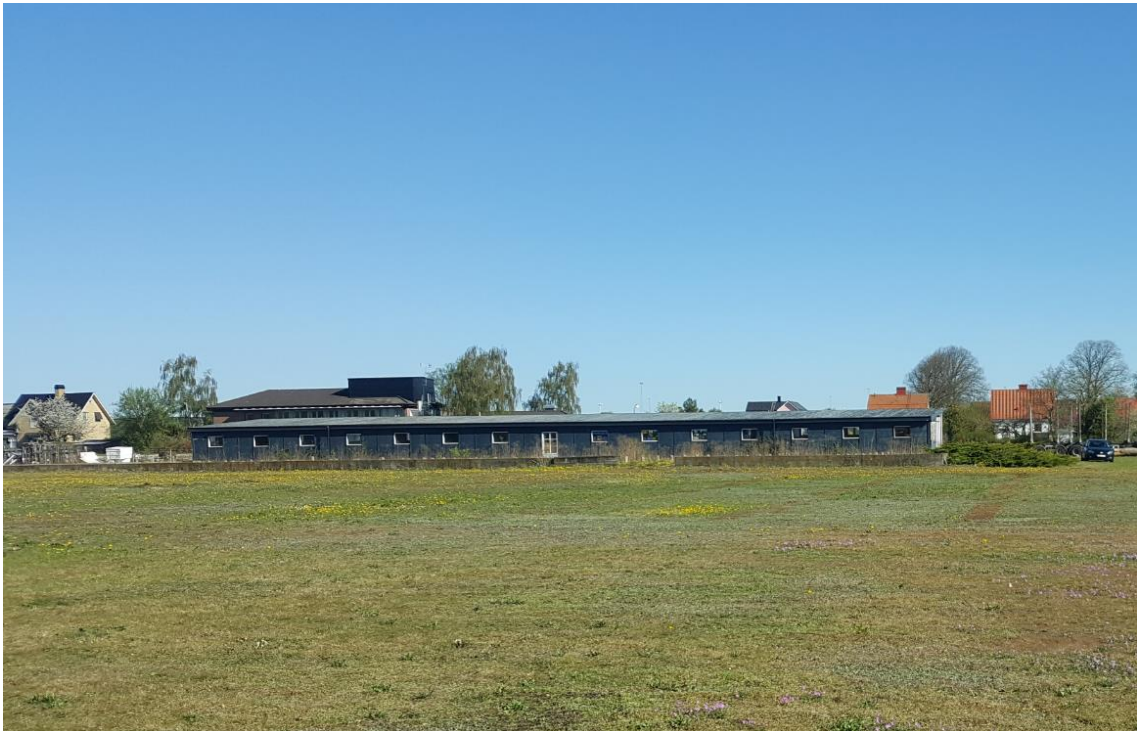
Figur 2. Befintlig byggnad inom undersökningsområdet.
