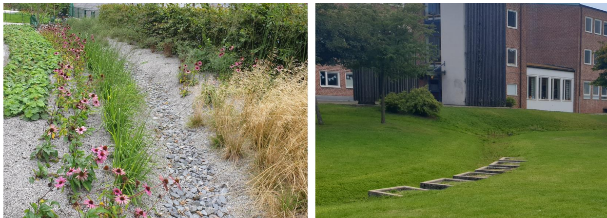
Figur 16 Svackdike med gruskrossfyllnad i mitten, Hammarby Sjöstad (t.v.) och stor överdämningsyta med svackdike, Augustenborg (t.h.)
