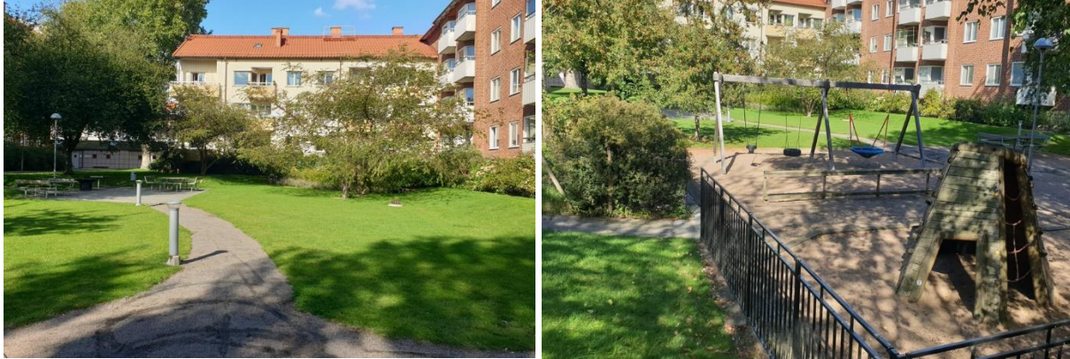
Figur 18 Överdämningsyta i Augustenborg. platsen är delvis grönyta med sittplatser, delvis lekpark. Ytan kan svämma över ca 30 cm vid skyfall. I den lägsta delen ligger en kupolbrunn upphöjd för att forcera infiltration av mindre regnmängder
