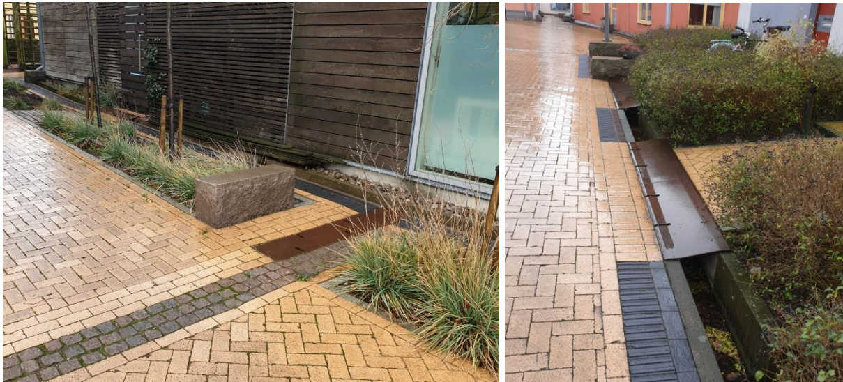
Figur 19 Öppna kanaler längs fasader och körbar kanal under gång- och körbana (Bo01, Malmö)
