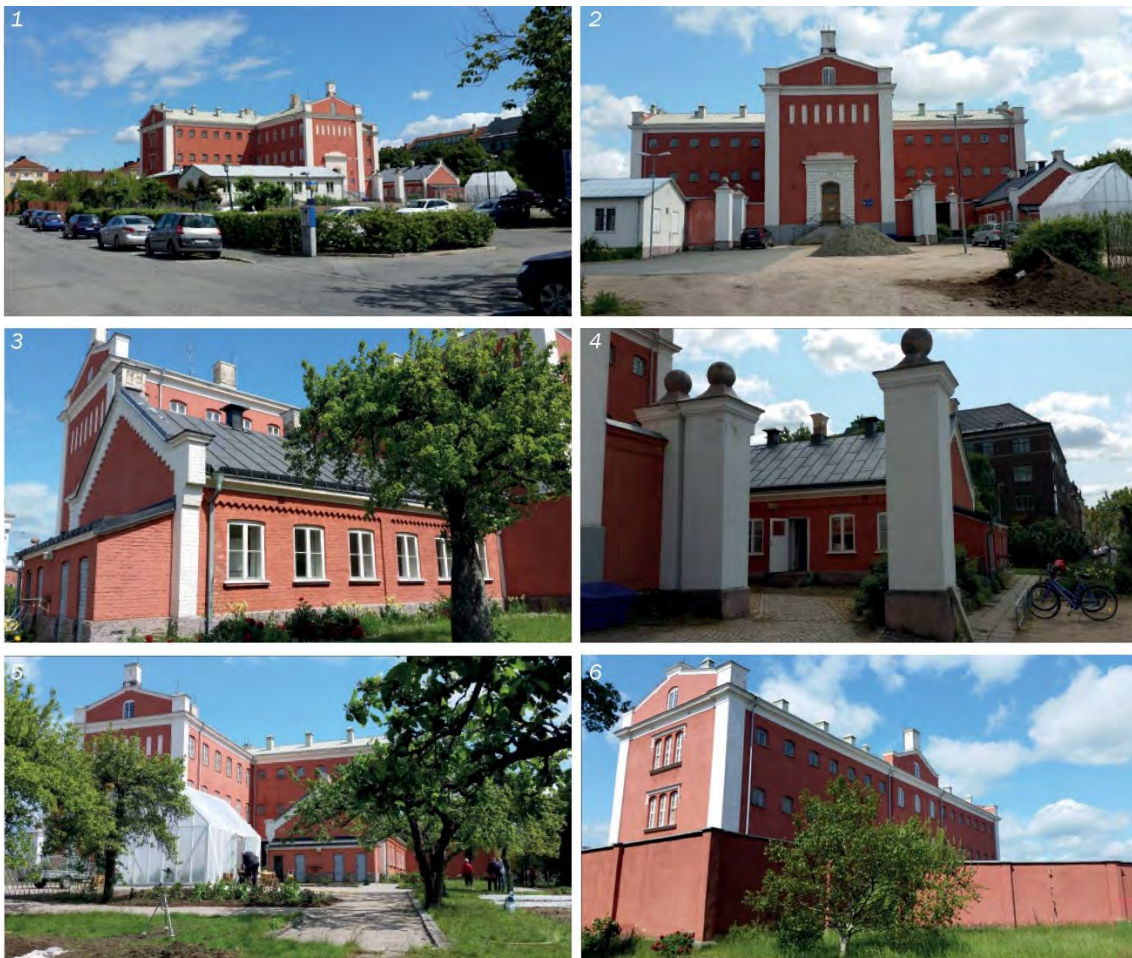
(1) Bebyggelse inom området sett från Fästningsgatan. I förgrunden syns infart till parkeringsytor i planområdets västra del. (2) Fängelsebyggnadens entré och gavel mot väster. (3) Den södra flygeln sedd från söder (4) Den södra flygeln sedd från norr/Fängelsebyggnadens entré. (5) Köksträdgården i planområdets södra del (6) Fängelsebyggnaden och muren sedd från sydost. (Bilder från planprogrammet)
