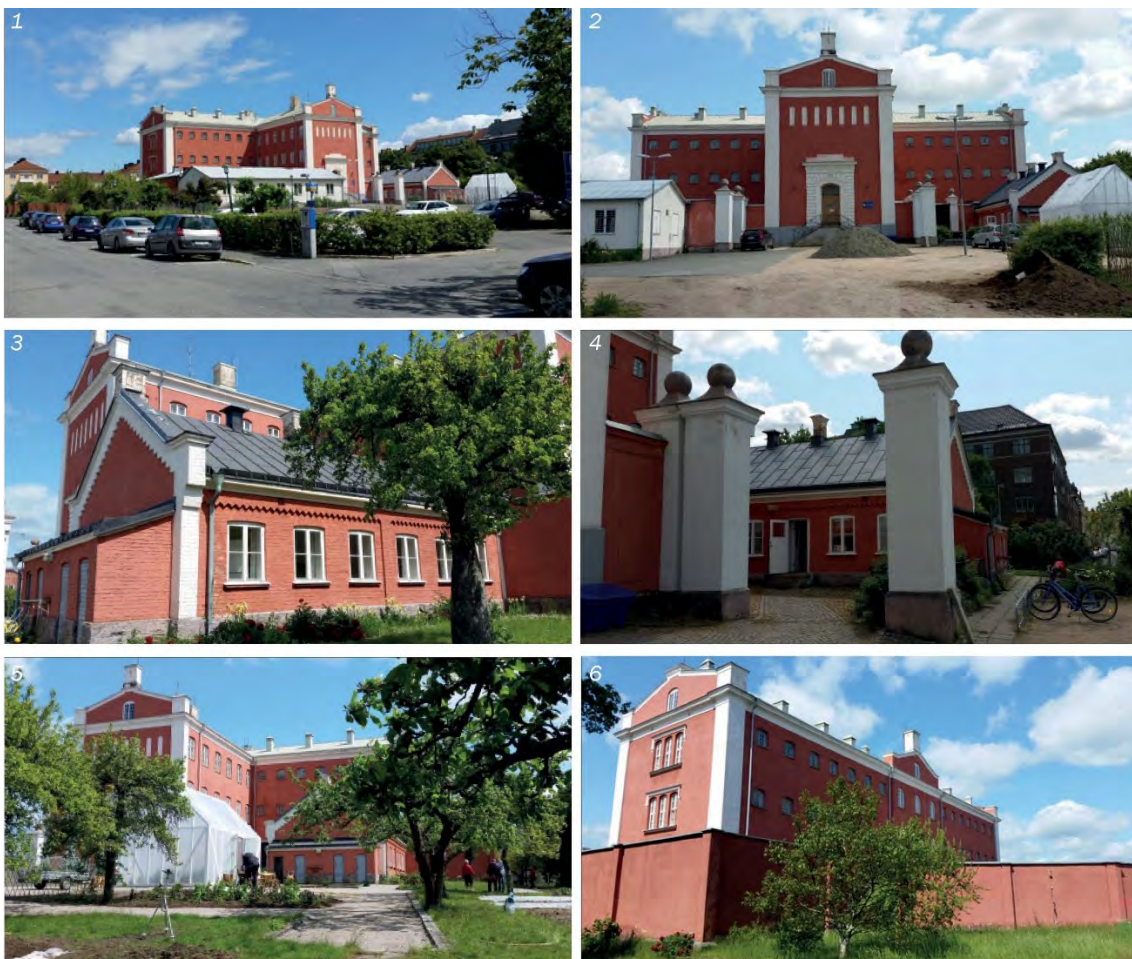
(1) Bebyggelse inom området sett från Fästningsgatan. I förgrunden syns infart till parkeringsytor i planområdets västra del. (2) Fängelsebyggnadens entré och gavel mot väster. (3) Den södra flygeln sedd från söder (4) Den södra flygeln sedd från norr/Fängelsebyggnadens entré. (5) Köksträdgården i planområdets södra del (6) Fängelsebyggnaden och muren sedd från sydost. (Bilder från planprogrammet)
