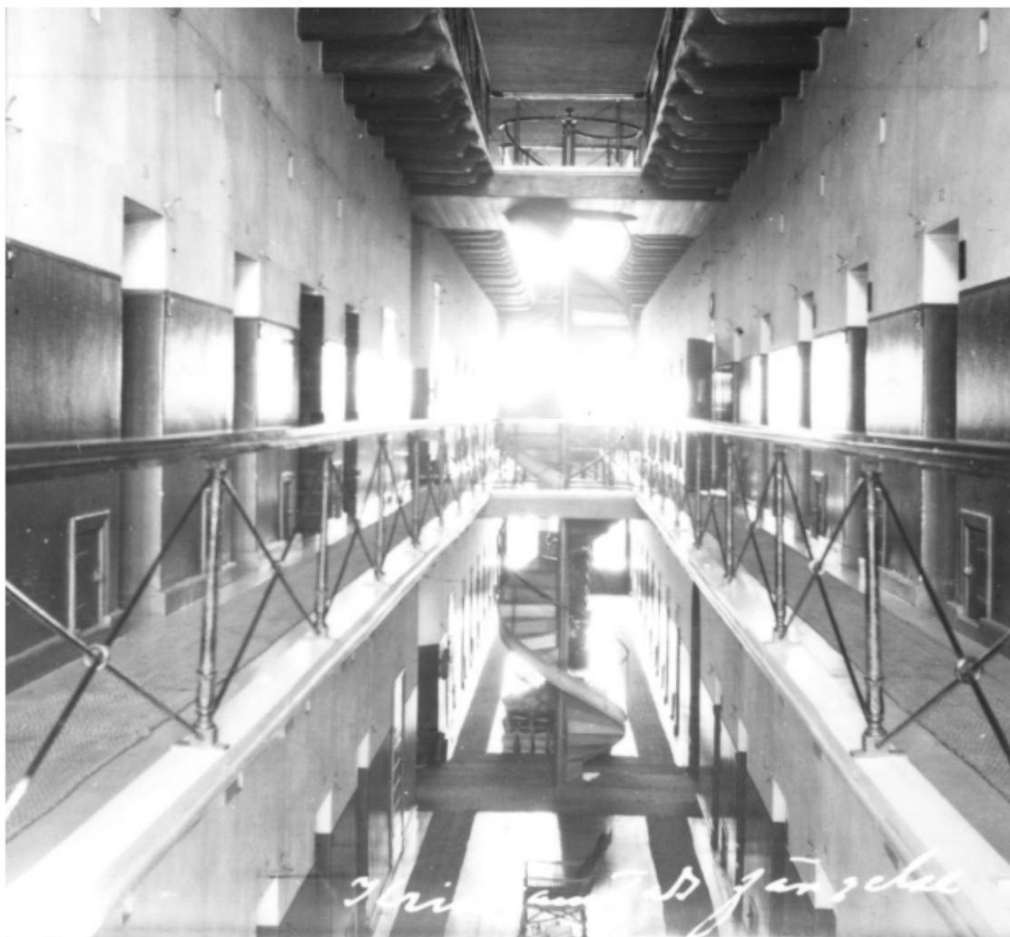
Interiör från cellängan 1905. Mellan våningsplanen fanns ett öppet ljusschakt för att underlätta övervakning. Längan fick naturligt ljus från fönstren i gavlarna och lystes i övrigt upp av fotogenlampor. Observera de små luckorna på sidan om celldörrarna, där nattkärlen kunde placeras så att dörrarna inte behövde öppnas. Ljusschakten byggdes igen under 1950-talet. Bild ur Regionsmuseet Skånes arkiv. Källa: Kulturhistorisk värdering, Fängelset 2, Regionmuseet Skåne, 2022-04-05
