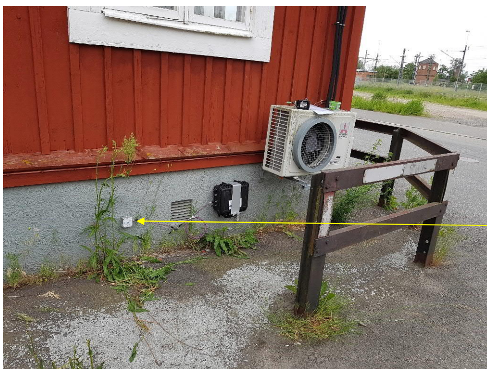
Figur 4. Placering av mätpunkt 4 i grundmur, träbyggnad
