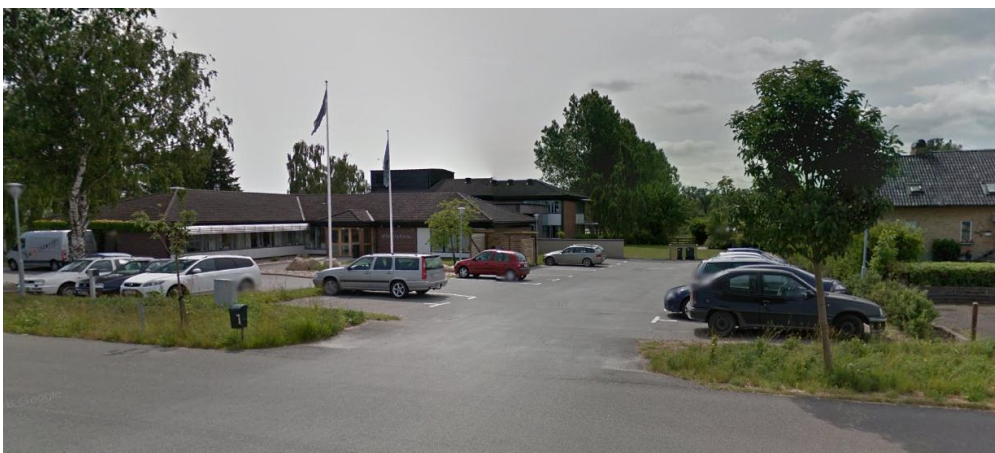
Figur 2: Vy mot aktuell byggnad från infarten vid Olof Mohlins väg. Byggnaden är i ett plan och en mindre del av den i fotot bakomliggande delen är i två plan.
