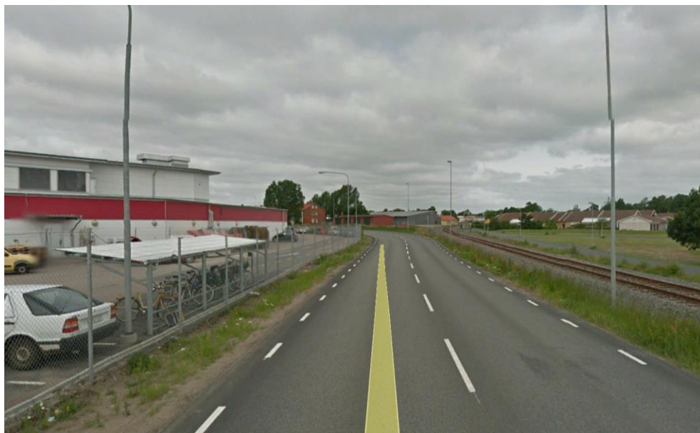
Figur 6. Placering av befintlig bebyggelse relativt Hamnbanan och Åhusbanan.
