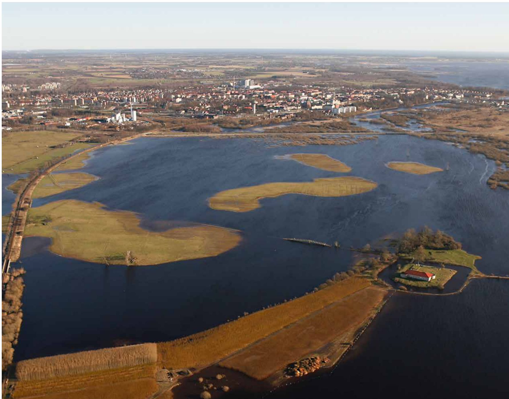
Vid högt vatten i Helgeå är det risk att Kristianstad översvämmas. Planen för vallutbyggnad ska skydda mot högt vattenstånd mer än 100 år framåt i tiden.
